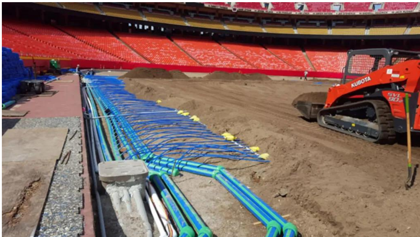
Instalação do sistema de aquecimento no Arrowhead Stadium, ca. 2016. (Foto: Chefes de Kansas City)
